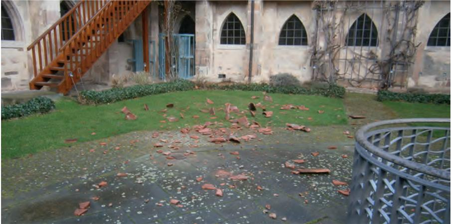
Herabgestürzte Dachziegel im Innenhof des Kreuzganges ausgelöst durch vom Sturm abgehobene Firstziegel. Herabstürzende Ziegel durchschlugen dabei auch stellenweise die Dachflächen.
