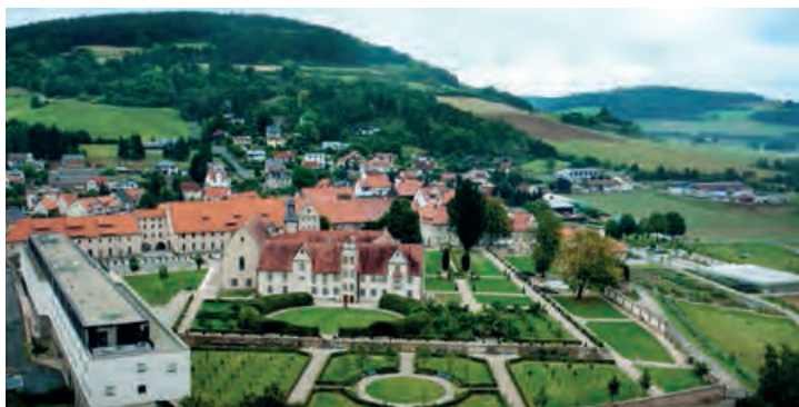
Bild 8 Haydau Gesamtanlage Foto: Florian Funck
