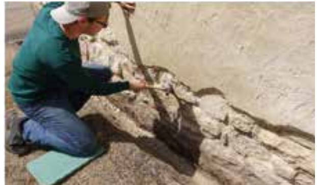
Tief schürfen für einen festen Halt – Herr Wegner bei den Fassadenarbeiten am Südgiebel des Westflügels
