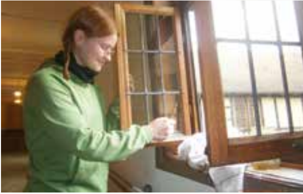
Mit ruhiger Hand zum Schutz der Fenster – Frau Platz beim Leinölanstrich der Innenhoffenster im Ostflügel
